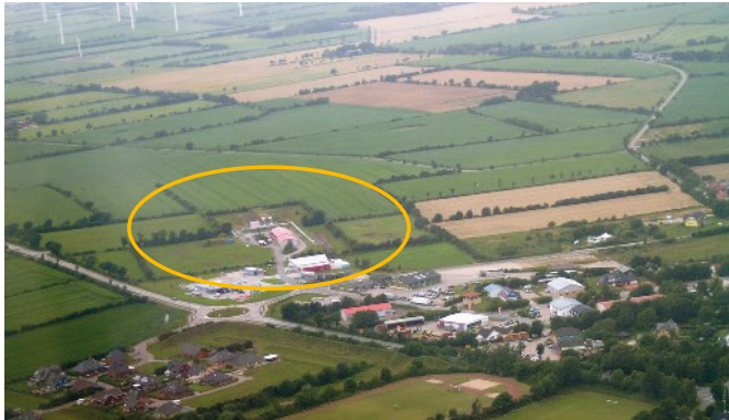
Unser Flüssiggaslager Schuby
